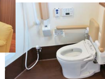
各居室内のトイレ
